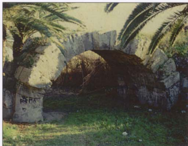
Santa Marinella. Ponte sulla via Aurelia.
